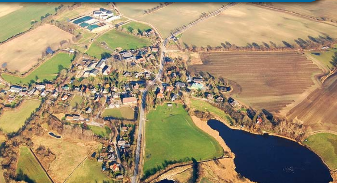
38 Häuser der Gemeinde Honigsee wurden in 2007 an das eigene Nahwärmenetz angeschlossen.
